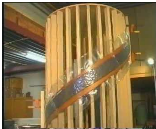
Le limon dans la poche, sur le gabarit. Serrez progressivement depuis le bas.
